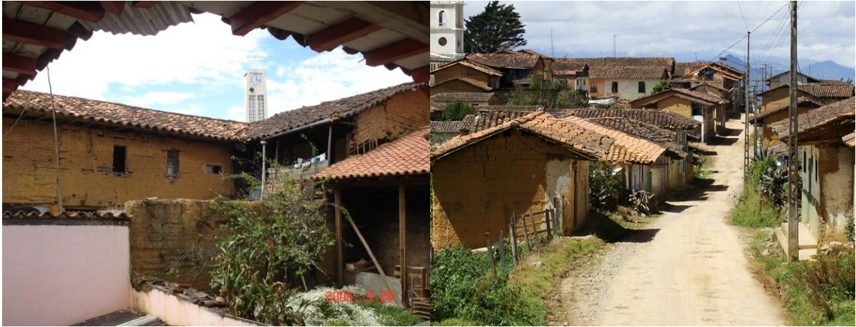
Viviendas construidas a base de adobe y teja Fuente: Patricio Riofrio, 2006
