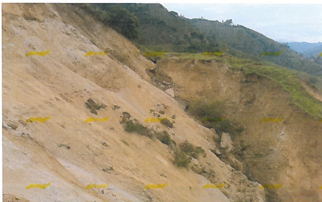
FOTO 5: DESLIZAMIENTO DE PLATAFORMA Y CANAL PRINCIPAL.
