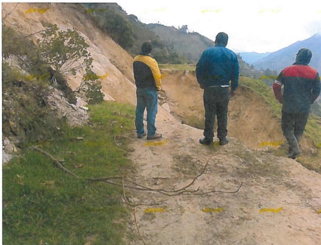
FOTO 6: DIMENSIÓN DEL DESLIZAMIENTO DE PLATAFORMA Y CANAL PRINCIPAL.
