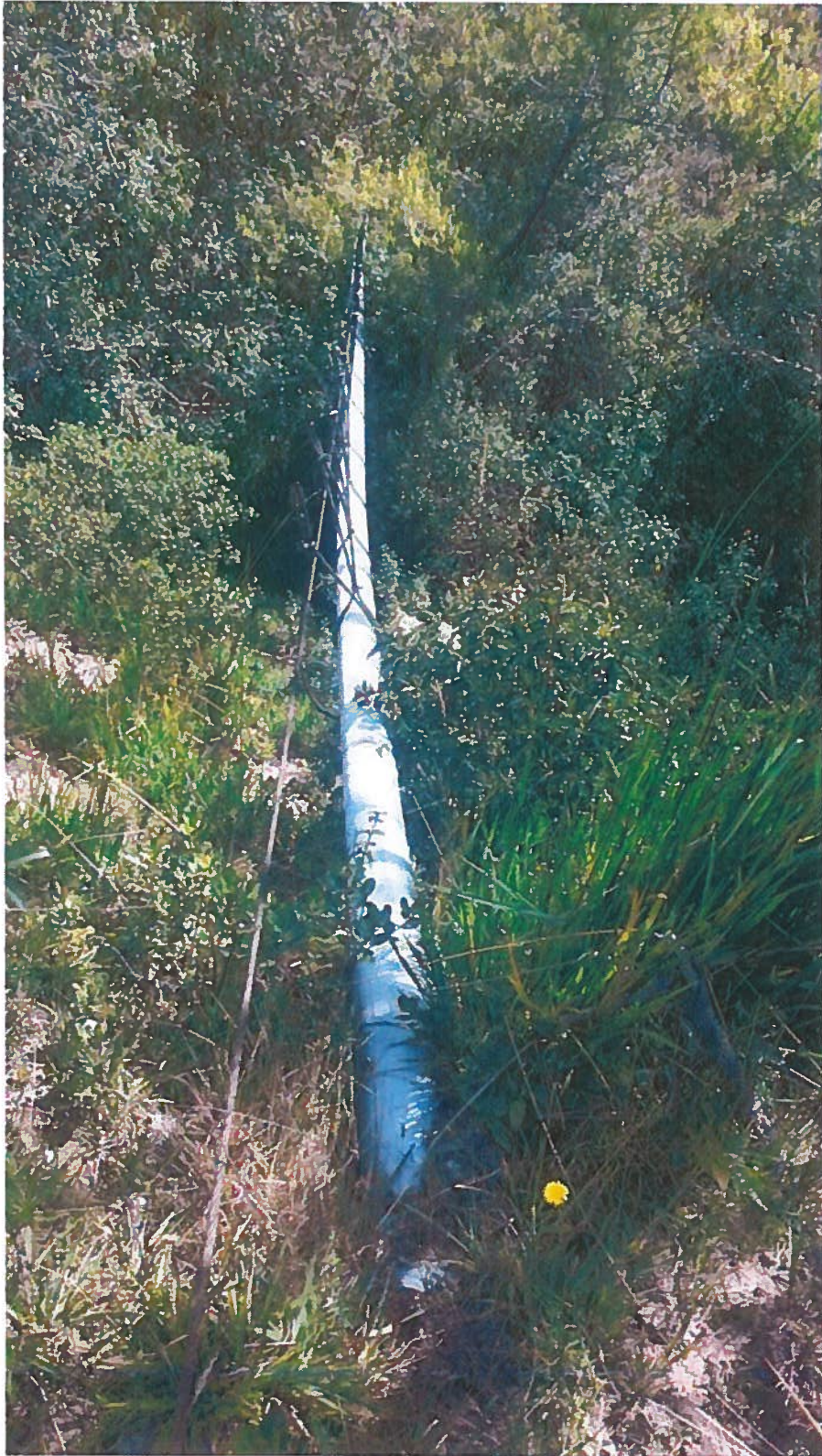
Foto 5. Paso elevado en red secundaria del sistema de riego Santiago
