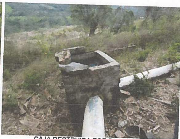
CAJA DESTRUIDA POR DESLIZAMIENTO
