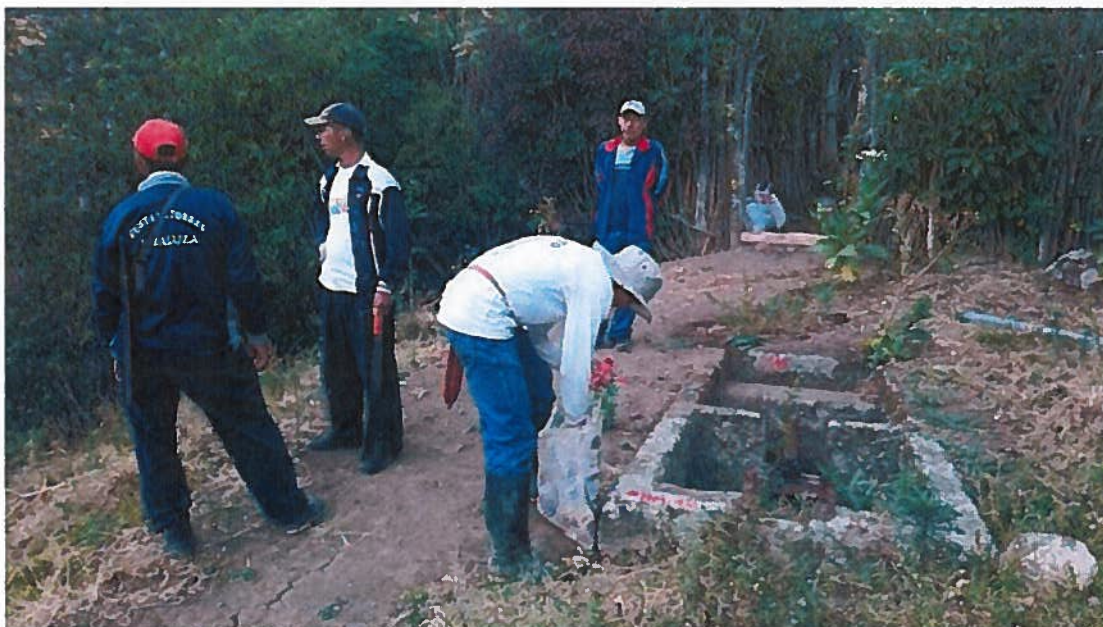
Foto 3. Tanque rompe presiones de los ramales secundarios
