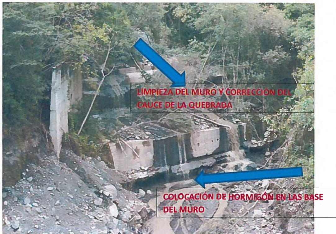
Los trabajos que está ejecutando la Junta de Riego son de carácter provisional que van a proteger la obra pública durante el periodo de lluvias, sin embargo hay que pensar en obras de largo plazo que permita estabilizar el cauce de la quebrada tanto en sentido longitudinal como transversal, debido a la alteración progresiva de la
