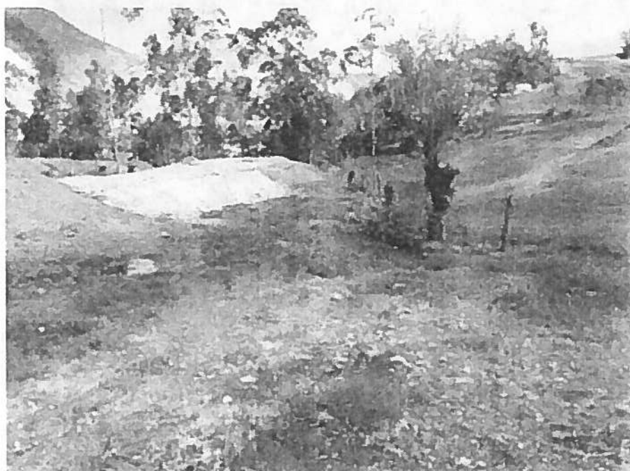
Foto 5. Tramo de vía nueva por empatarse
