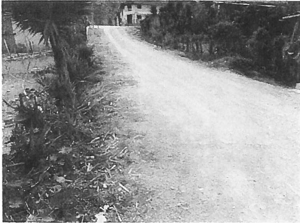
Foto 7. Paso de agua por vía principal del centro parroquial
