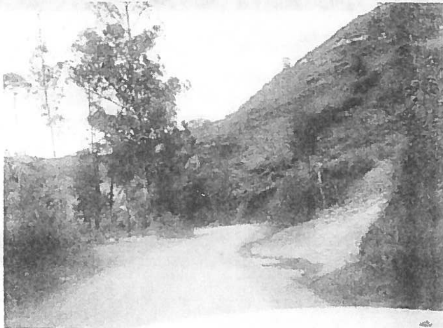
Foto 8. Paso de agua por vía principal del centro parroquia
