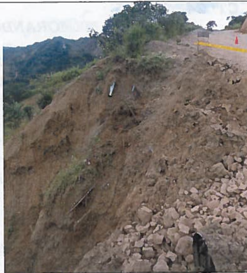
Foto 4. El ramal terciario pasa sobre una alcantarilla de la vía Intervalles
